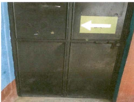
Mantenimiento de estructura (puerta) y cambio de chapa.
