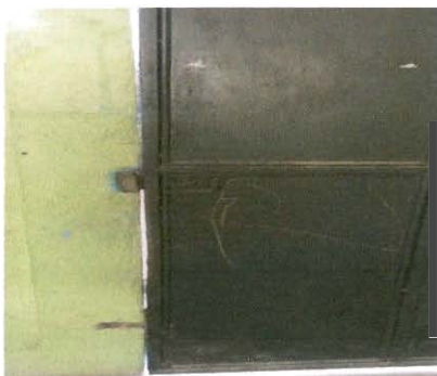
Mantenimiento de estructura (puerta) y cambio de chapa.
