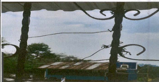
Sustitución de balcones de metal
